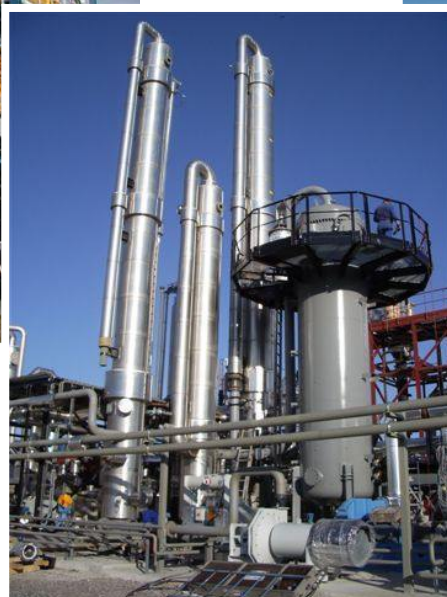
OLGA, Moissannes (F) CHP 1 MW e
